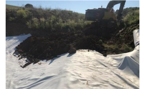
BETEX TP Vliesstoffe, Fa. Beco Bermüller GmbH Vliesstoff aus Polypropylen für typische Lösungen wie Filter-, Trenn- und/oder Schutzlage im Straßen-, Hoch-, Tief-, Garten- und Landschaftsbau.
